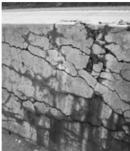
شکل ۵- نمونه هایی از آثار تخریبی بتن ناشی از انبساط قلیائی - سیلیسی
